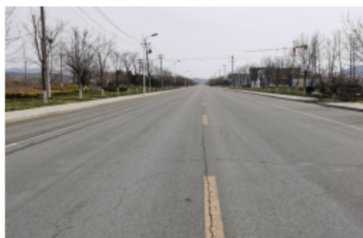
羊亭镇羊汪线北段：维修前
